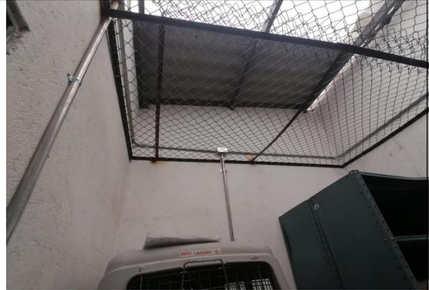
**Foto 20. Zona de Mamíferos.** Detalle de las adecuaciones recientemente realizadas en esta zona, la cual incluye el enmallado del techo para evitar escapes y renovación del cableado eléctrico.
